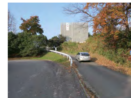
幅員の取れていない車道
