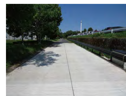
改質フライアッシュを用いたコンクリート舗装
