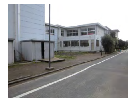
歩道が整備されていない幹線道路
